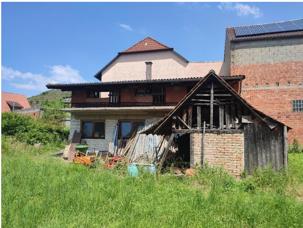
Abb. 3: Gebäude auf dem Flst. Nr. 118/1.
